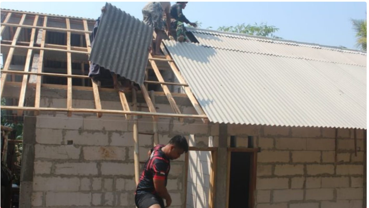
Pengerjaan RTLH Desa Pejengkolan Sudah Mulai Pemasangan Atap Rumah
