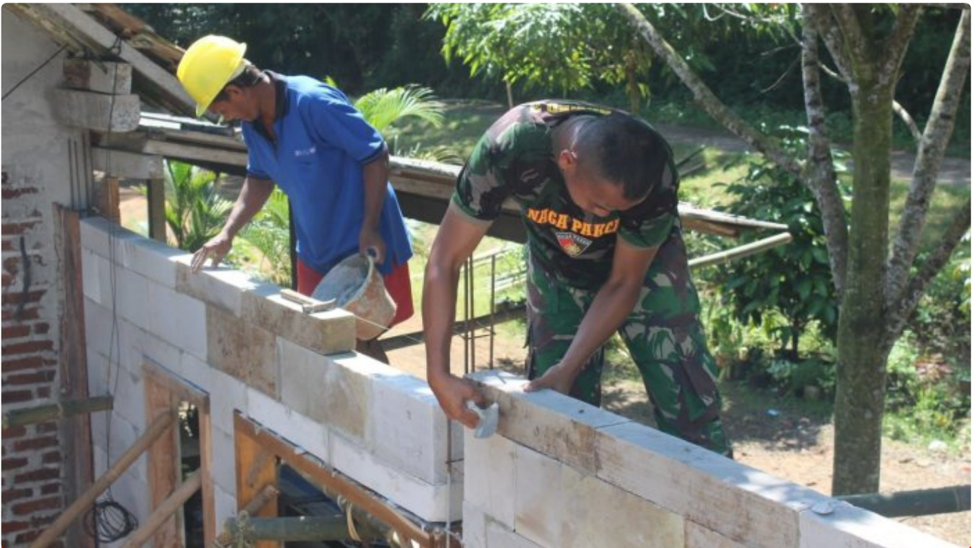
Pemasangan bata di rumah Bp Riyanto pembangunan RTLH
