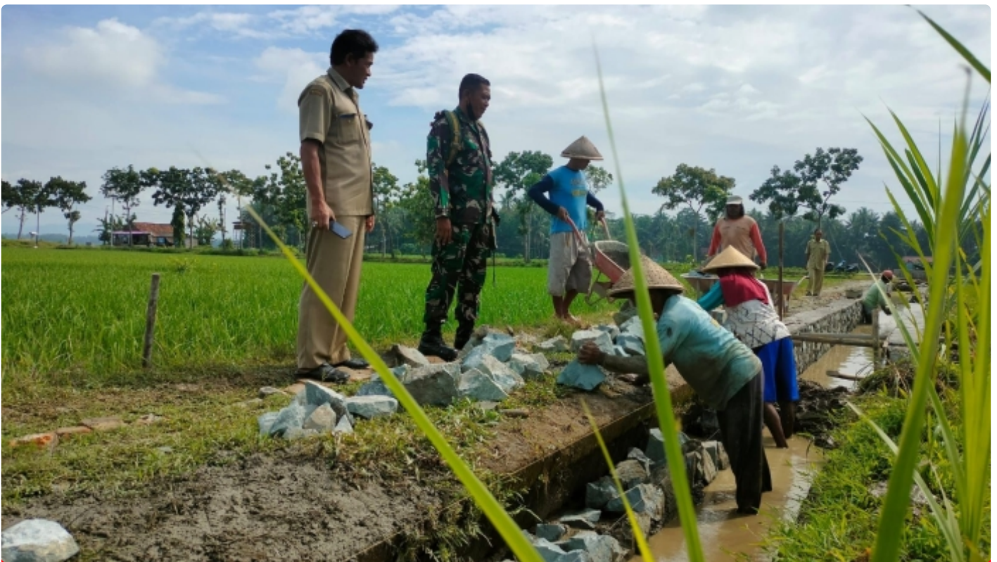
Babinsa Koramil 15/Klirong Pelda Bambang PH mendampingi Pemerintah Desa (Pemdes) cek pembangunan saluran Drainase yang bertempat di Desa Jerukagung
