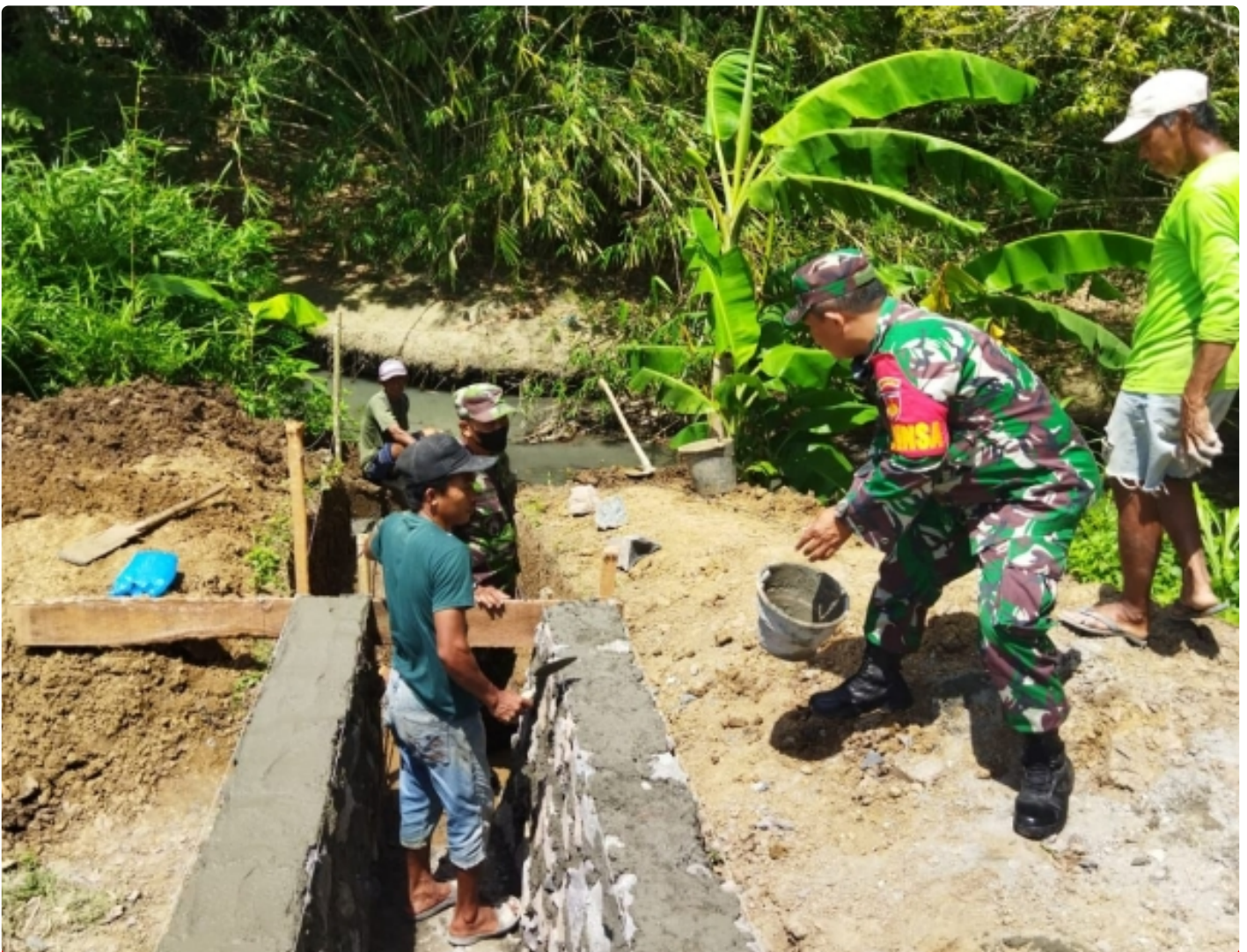
Babinsa Koramil 15/Klirong Bantu Warga Dalam Perbaikan Drainase Dan Gorong-Gorong Parit Jalan
