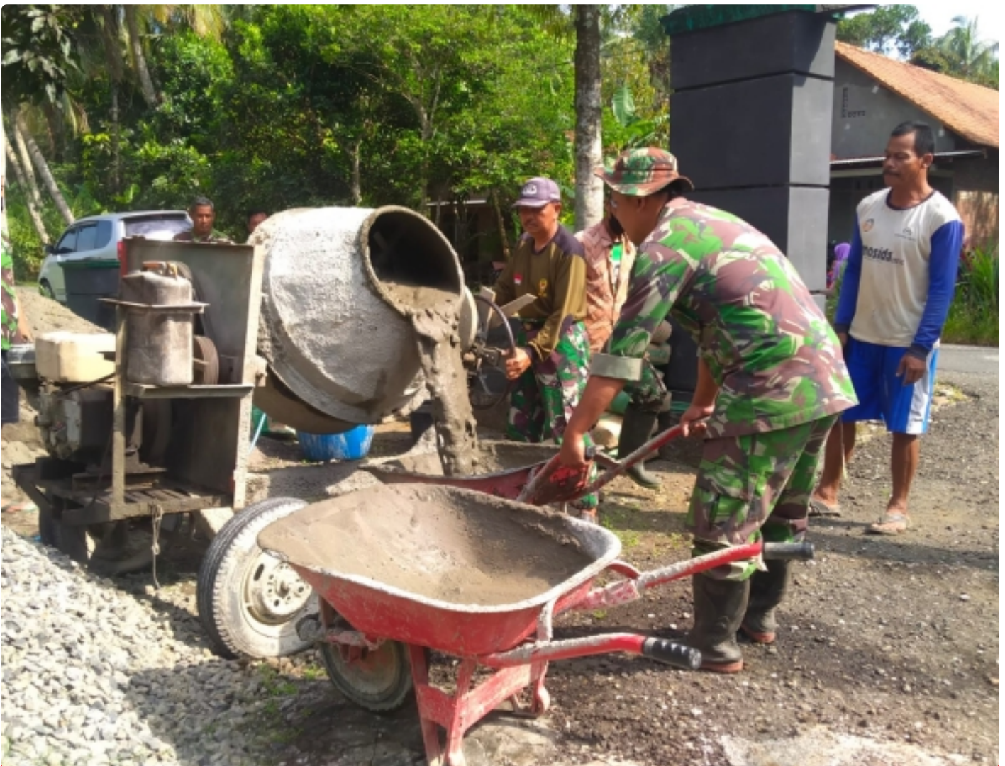
Anggota Posramil Bonorowo Bantu Warga Pengecoran Jalan
